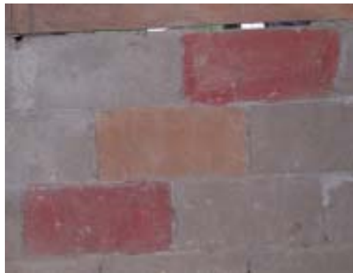
ໃຊ້ຄັ້ງທາສີຝາເຮືອນ ເປັນສີແດງ ຢູ່ບ້ານຫ້ວຍເຫລັກ, ເມືອງອຸຍ, ແຂວງຫລວງພະບາງ ໃນປີ 2005.
